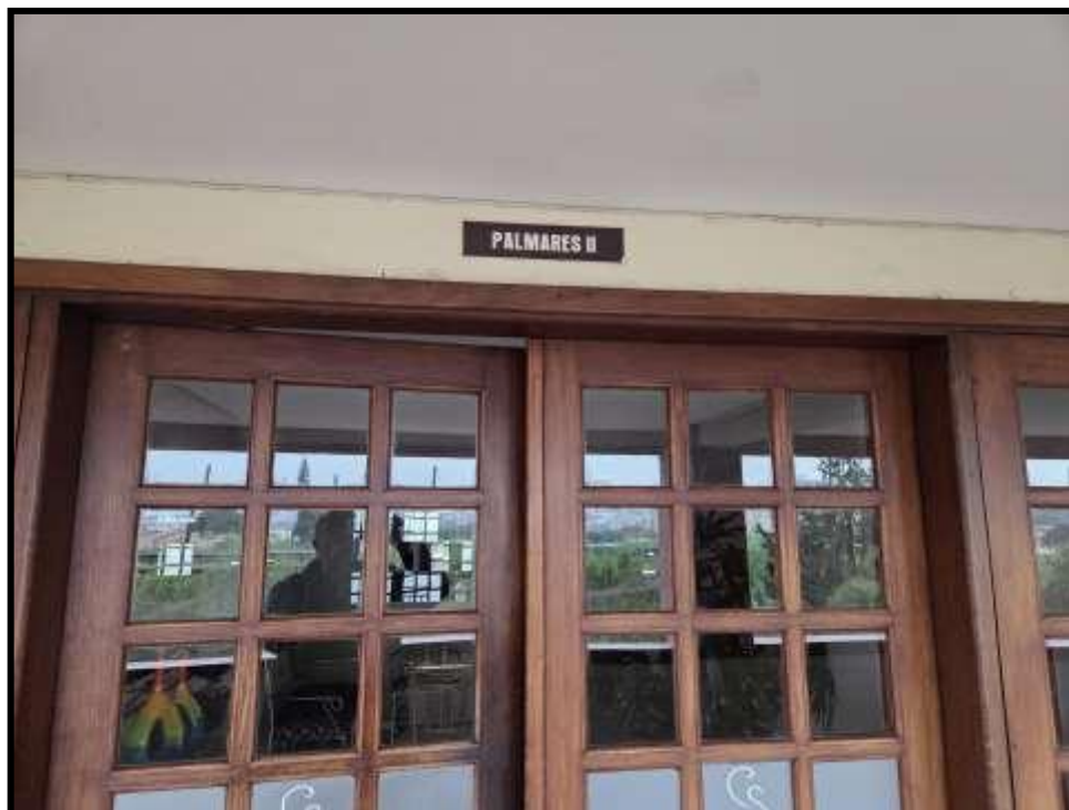
3. Acesso ao Bloco II onde se situa o apartamento em questão (nº 77).
