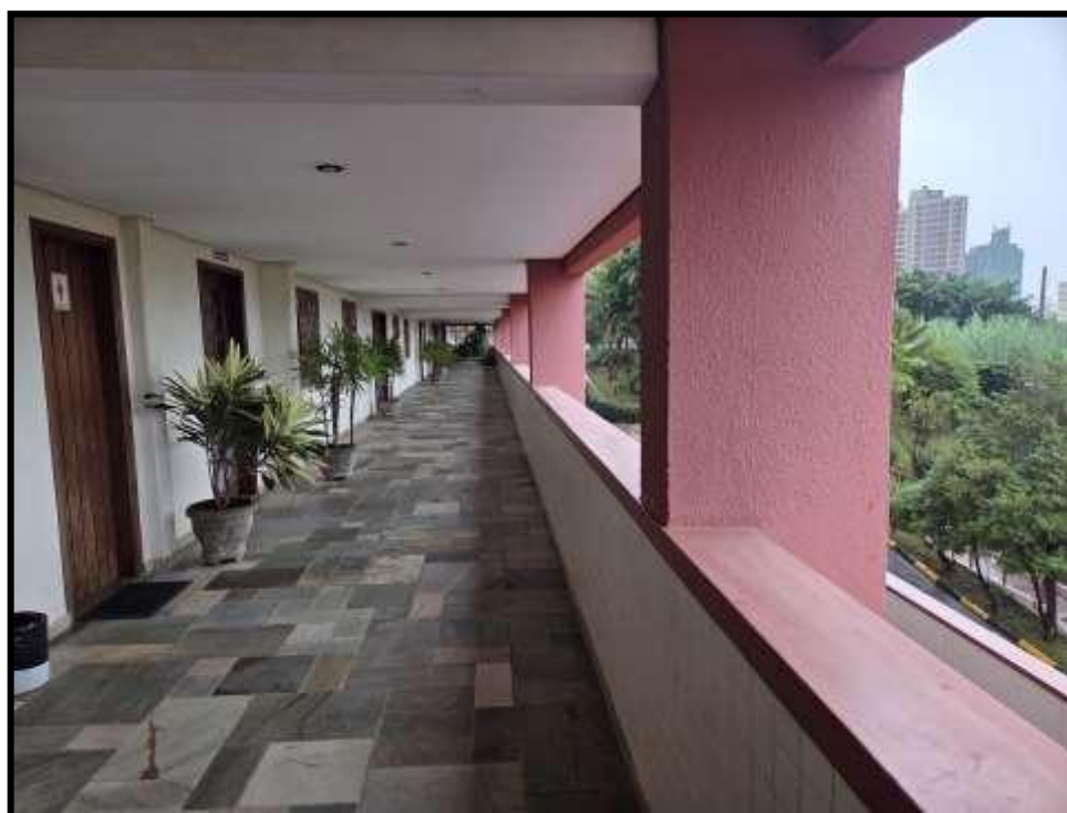
3. Corredor de acesso aos Blocos I e II.
