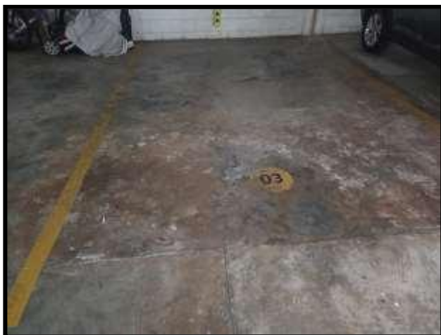
16, Box de Garagem nº 03 – 2º subsolo.
